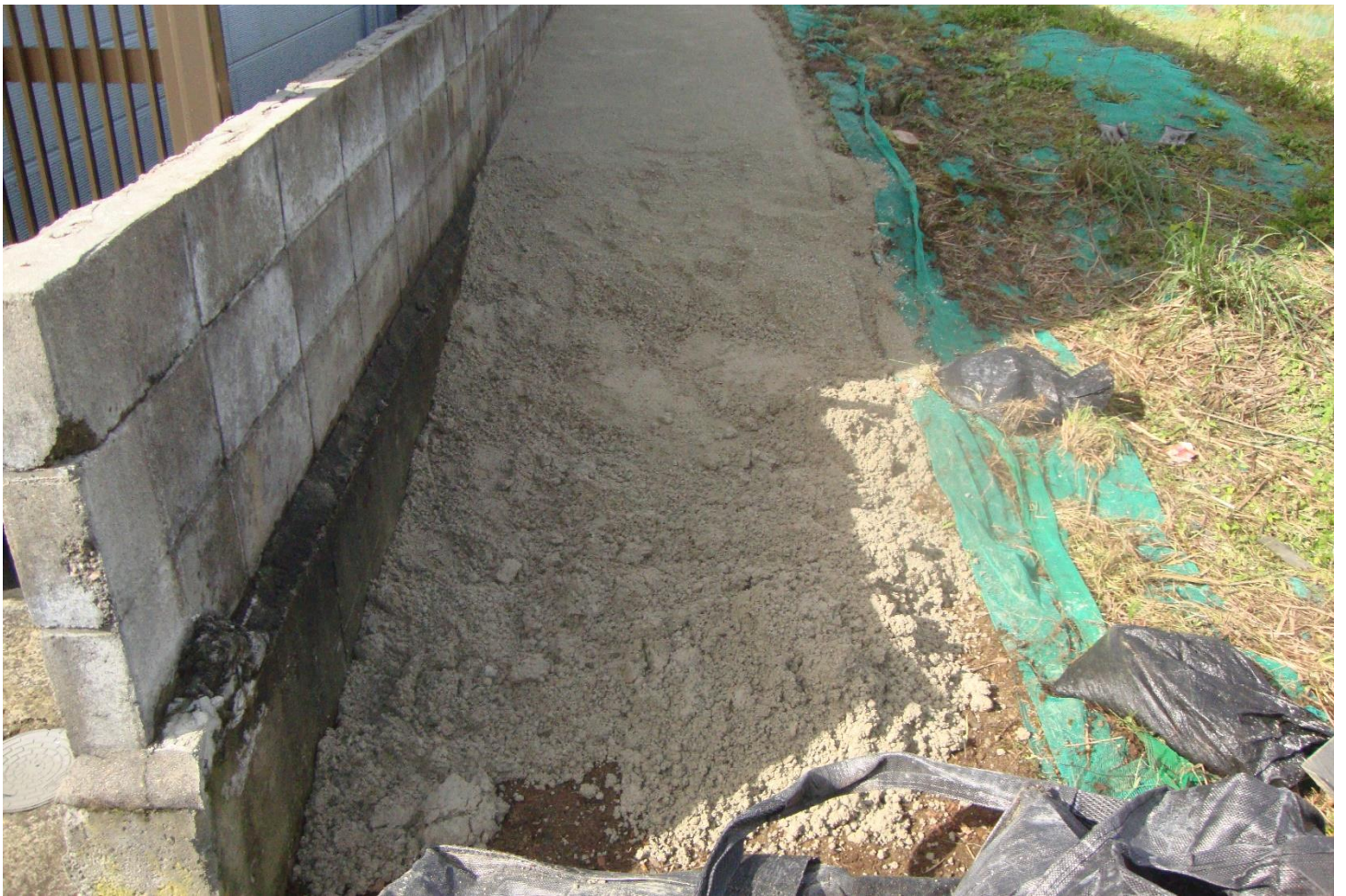
10月5日、入口部分を施工します。
