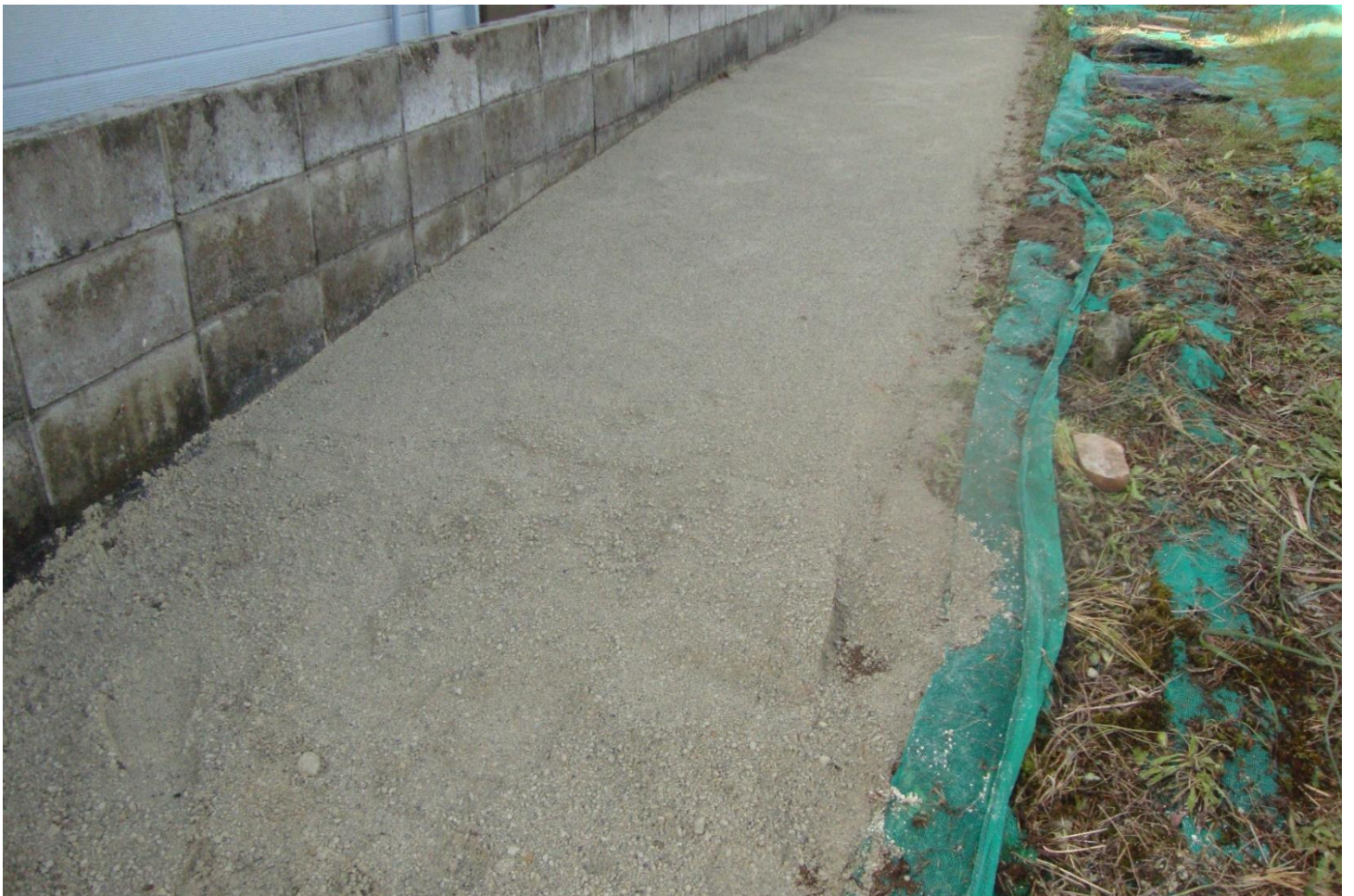
前日、雨が降ったので表面の仕上がり（流れ、へこみ、型くずれ）を確認します。
