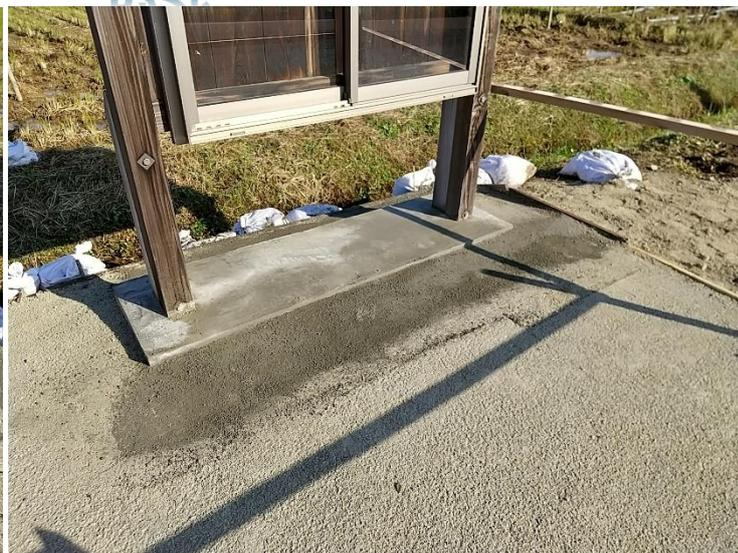
コテで叩いてからジョウロで少量散水しました。セメントを含んでいるので色が違います。この先の天気は晴れなので特に養生（板で雨だれ対策）はしませんでした。散水後、コテを使うと R サンドが附着して表面が凸凹になります。散水量が多いと表面の微粒分が流れ出しますので、噴霧器の方が良さそうです。ある程度固結した時点でバリケードと木枠を外しますが、車両の乗り入れは禁止とします。
