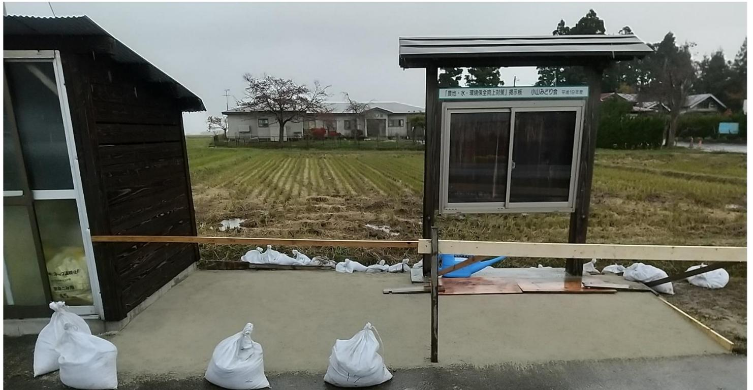
12:07 突然の豪雨で作業を中止、掲示板の雨だれでRサンドに穴が開くのを板で防止、仮バリケードを設置
