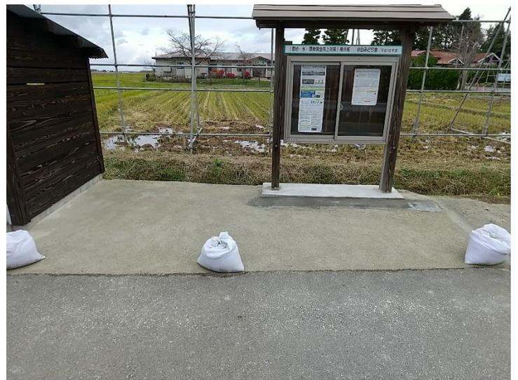
Rサンド施工 令和6年11月11日 施工時間・180分 施工面積・11.5㎡
